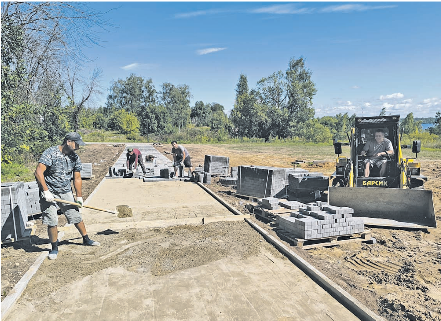
На текущей неделе будет закончена укладка тротуарной плитки и рабочие перейдут к следующему этапу работ
